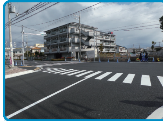
伊丹市 ：山田伊丹線。市の南西部から中心へ向かう道路整備でネットワーク強化に繋がります。 9,845万円
