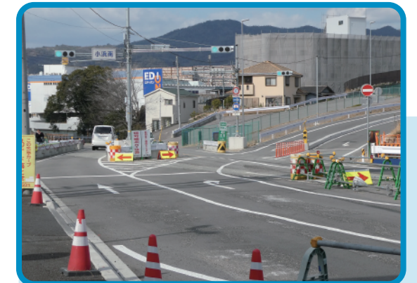
宝塚市 ：尼崎宝塚線小浜南。宝塚インターの入口の混雑を緩和する工事で継続的に進行中です。 9,450万円
